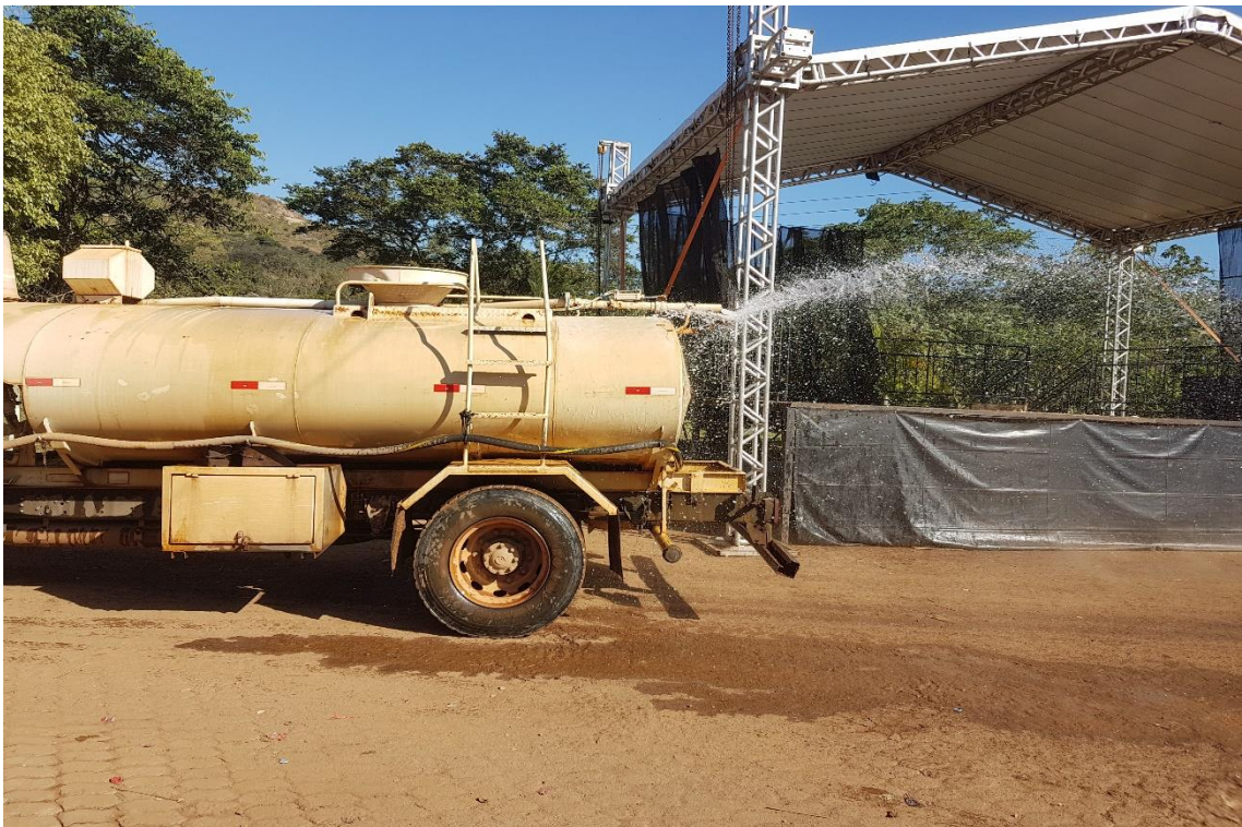
Figura 4. Aspersão de via com Caminhão Pipa
