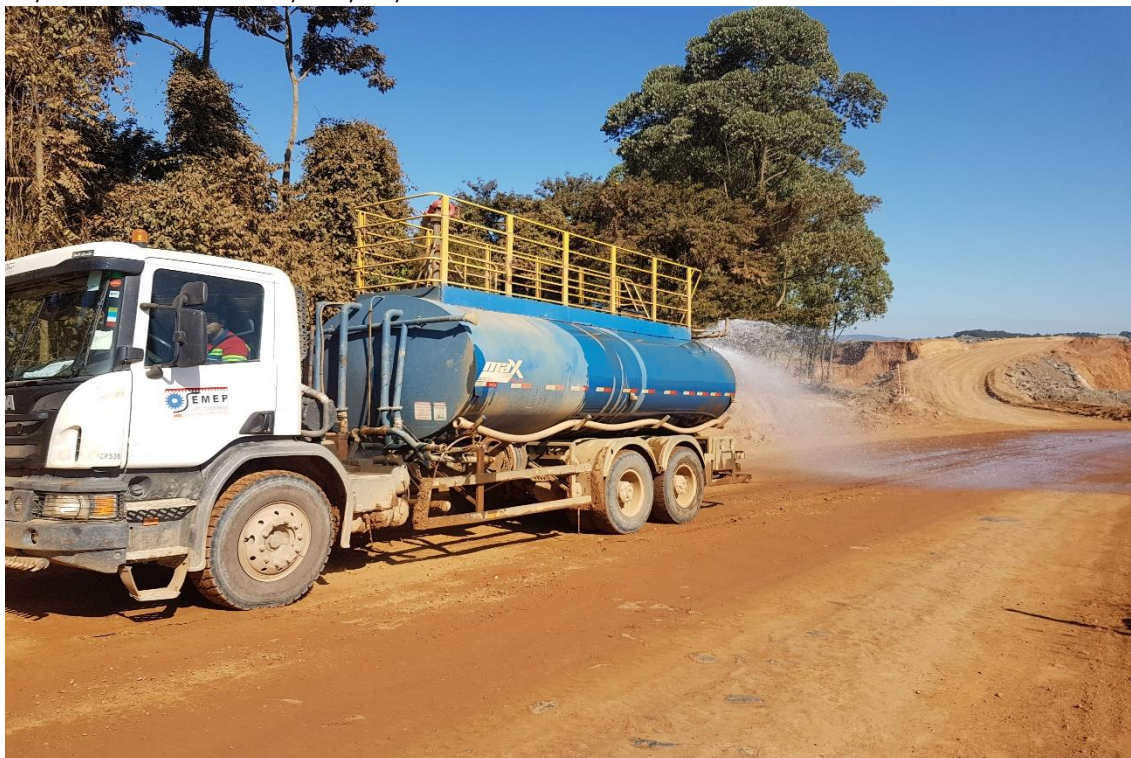
Figura 2. Aspersão de via interna com Caminhão Pipa
