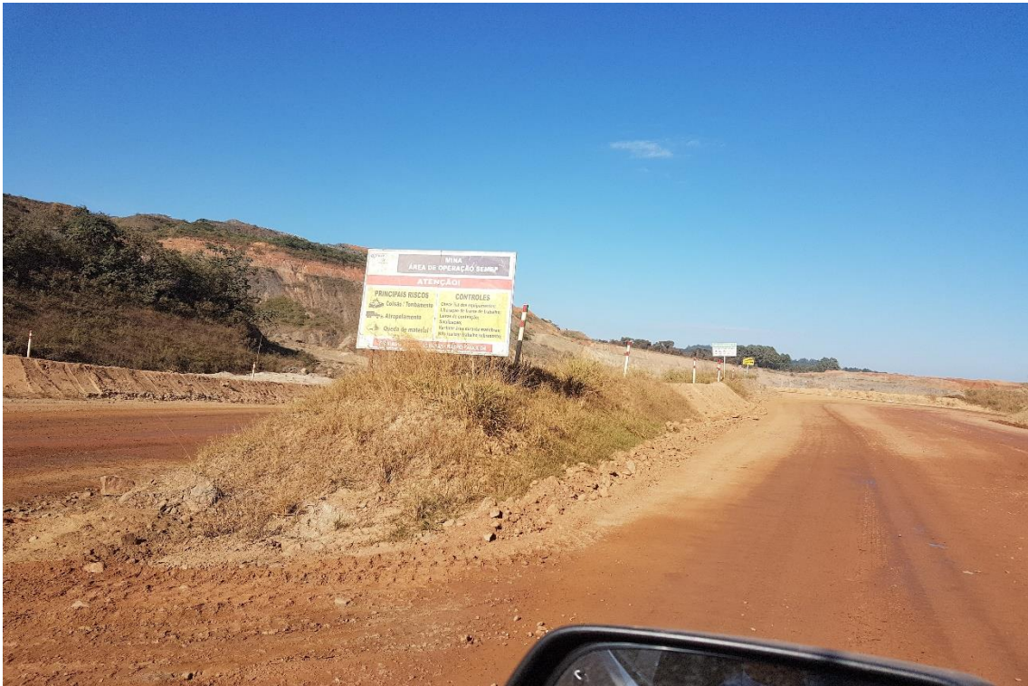
Figura 12. Placa de sinalização de acesso da Mina Corpo A.
