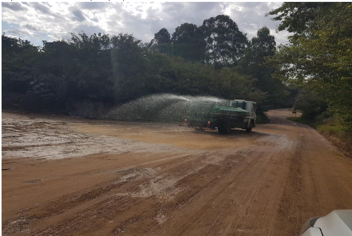
Figura 5. Arpersão de via externa com caminhão Pipa.
